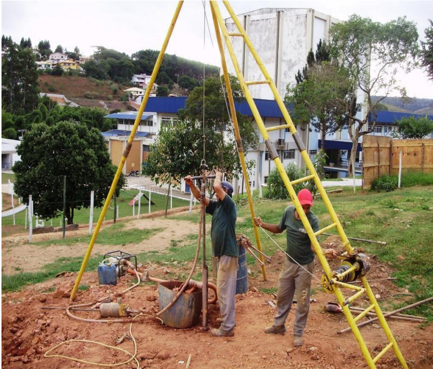
Figura 12 – Realização de sondagem SPT na Av. M a de Paula Santana, nº 3815. Fonte: Geopontuall, 2014.
