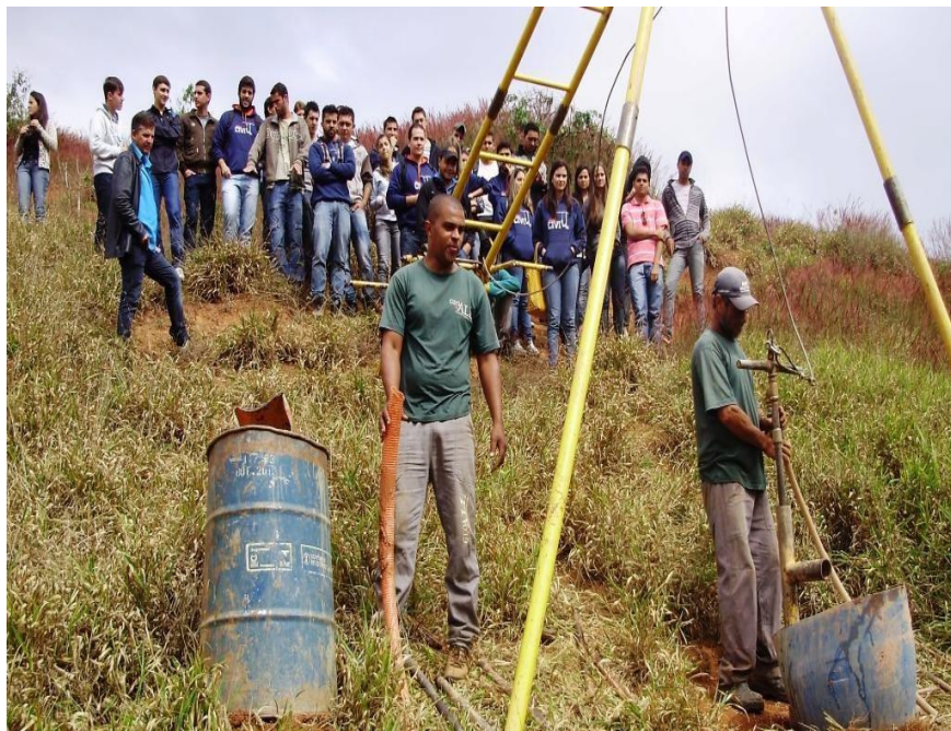
Figura 13 – Realização de sondagem SPT na Rua Joaquim Lopes de Farias. Fonte: Geopontuall, 2014.
